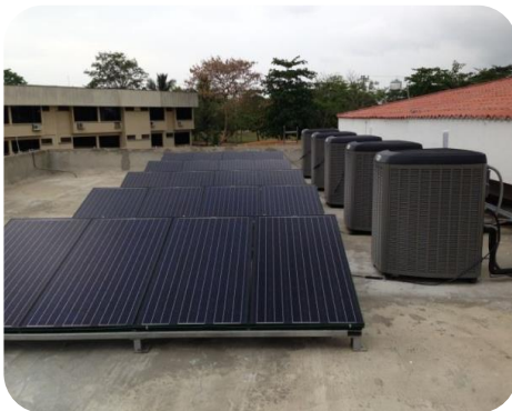
Equipos de Aire Acondicionado Híbridos con Sistema Solar CACOM-1-3-4 EMAVI
